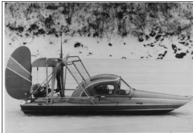
図10a サイクロン 型 BMW35馬力、4.3mL x 2.1mB、275kg(軽荷)、4人、475kg(満 載)、47km/h(水上)静止推力135kg(28.4%満載)、1958年完成
